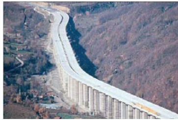
Şekil 5.1 : Bolu Viyadükleri genel görünüş.
