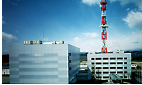
Şekil 2.6 : “The Computer Center of the Tohoku Electric Power Company” binası.
