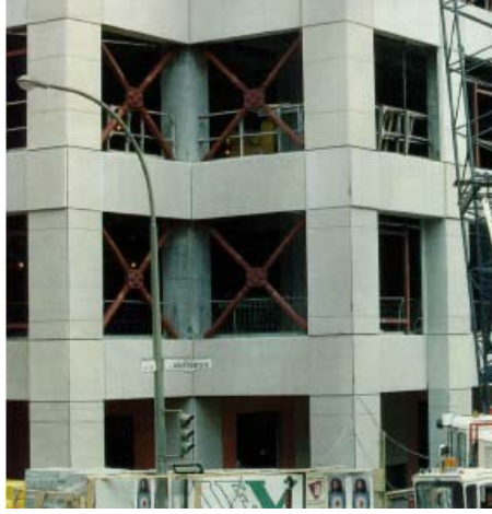
Şekil 3.25 : Sürtünmeli sönümleyici X tipi yerleşimi.
