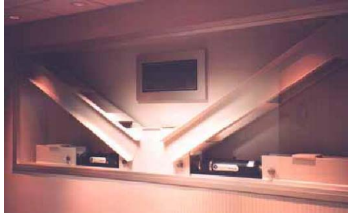
Şekil 3.27 : Viskoz sönümleyici örneği.
