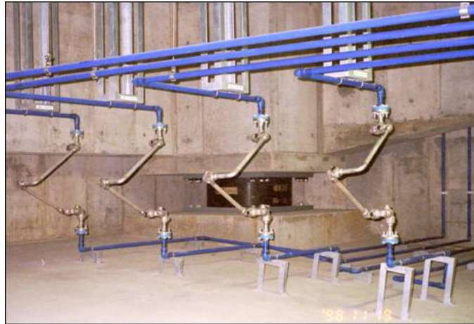
Şekil 3.7 : Özel ayırma detayları uygulanmış izolatör.
