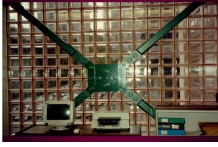
Şekil 3.24 : Sürtünmeli sönümleyici yerleşimi.
