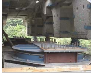
Şekil 5.2 : Bolu Viyadükleri'nde kullanılan sürtünmeli sarkaç izolatörü örneği.
