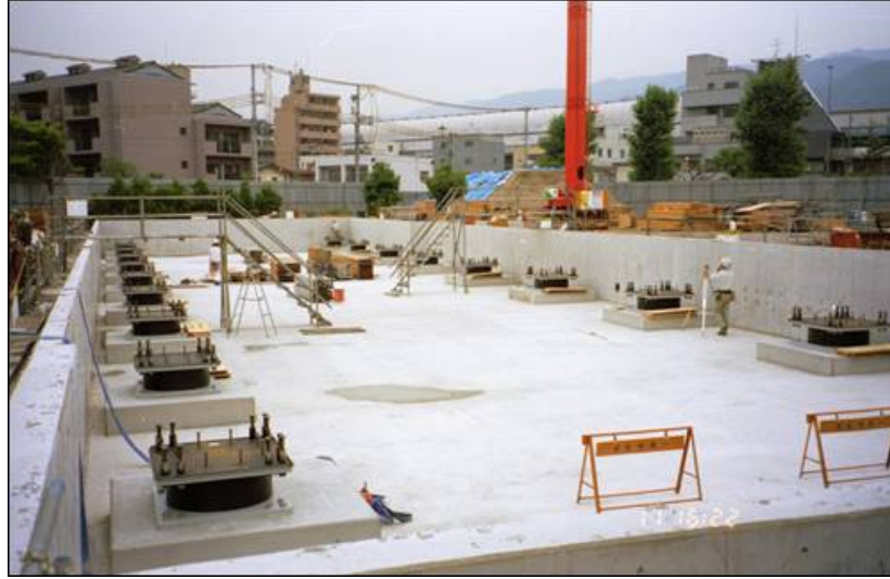
Şekil 3.2 : Temel üst kotunda yerleştirilen izolatörler.
