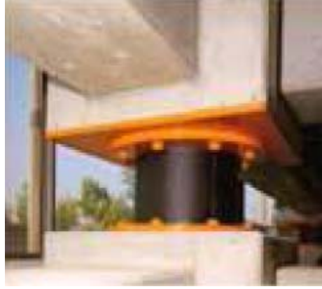
Şekil 3.12 : Düşük sönümlü kauçuk izolatör örneği.
