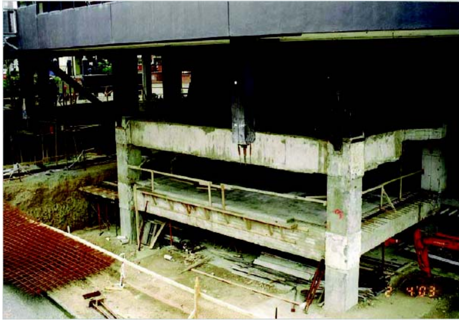
Şekil 2.15 : “Rankine Brown” Binasında kullanılan kauçuk izolatör.
