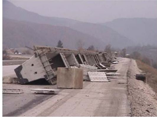
Şekil 5.6 : 2 nolu viyadüğün monte edilmemiş kirişleri.
