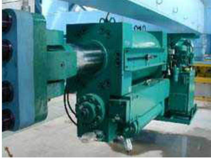
Şekil 2.10 : “Umeda DT Tower” Binasında kullanılan çok fonksiyonlu titreşim söndürücü.
