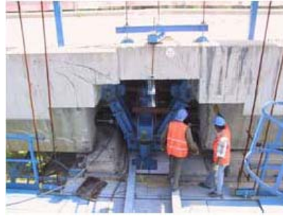
Şekil 5.4 : Üst yapının yeniden yerleştirilmesi ve dizaynı.
