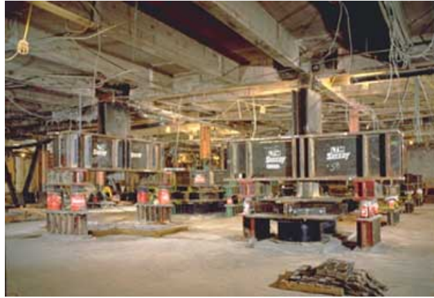
Şekil 2.3 : “San Francisco City Hall” binasında izolatör yerleşimi.
