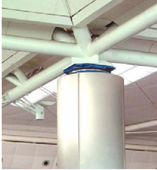
Şekil 3.20 : Atatürk Havalimanı çatısında kullanılan sürtünmeli sarkaç sistemi.
