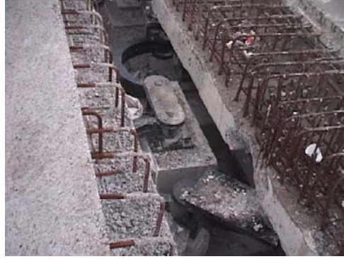
Şekil 5.7 : Histerik sönümleyicilerin deprem sonrası durumu.
