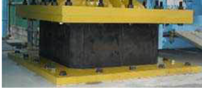
Şekil 2.9 : “Umeda DT Tower” Binasında kullanılan kurşun çekirdekli izolatör.
