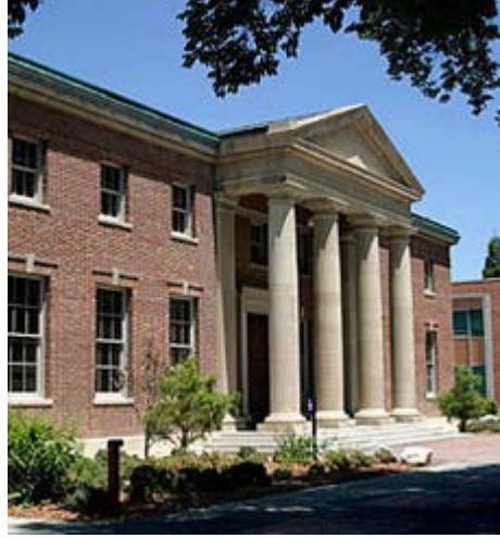
Şekil 2.4 : “Mackay School of Mines” binası.
