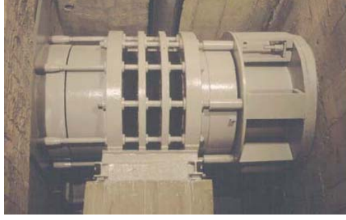
Şekil 2.18 : Samplago Viyadüğü'nde kullanılan kayıcı mesnet.
