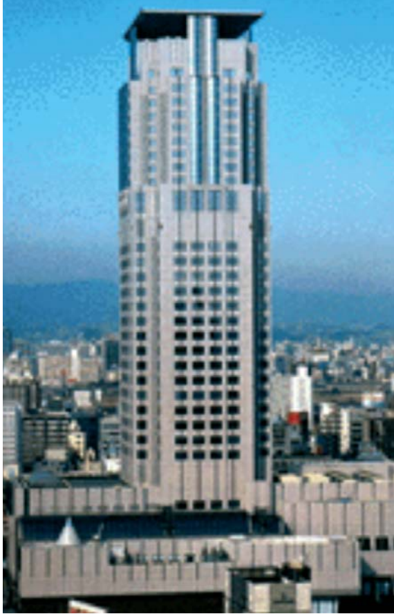
Şekil 18 - En Üst Katta AMD Bulunan Applause Kulesi, Japonya
