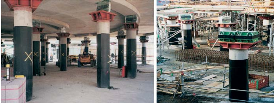
Şekil 15 - Kolon Üst Ucuna Yerleştirilmiş Yaylı Sistemler
